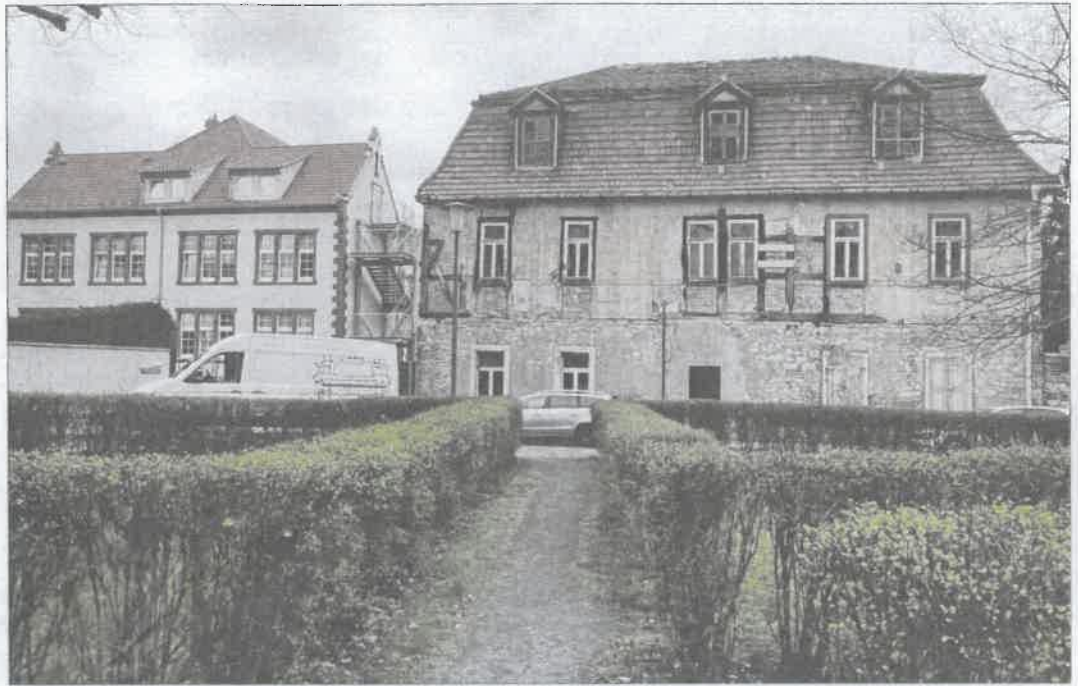
Vor 306 Jahren wurde die Alte Post errichtet, seit 24 Jahren steht sie leer. Nach Ende der Sanierung sollen zwischen acht und zehn Menschen hier in einer Wohngruppe leben.
