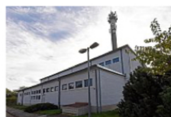
Das Heizhaus wird als Lager benutzt.
