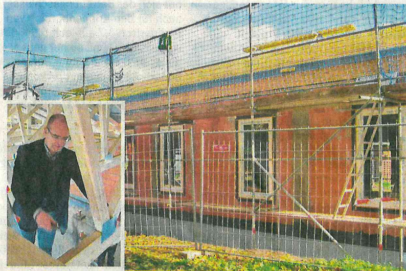
Richtfest für den neuen Flachbau im Schloß Hoym. René Strutzberg schlägt den letzten Nagel ins Gebälk.
