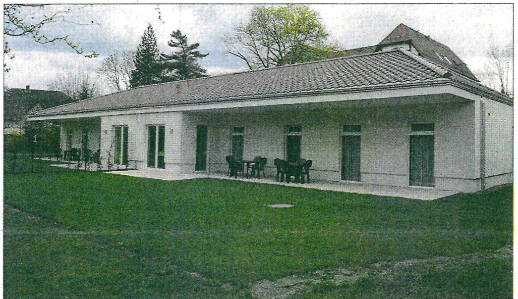
Klare Linien und ein nach Süden ausgerichteter Gemeinschaftsbereich soll den Menschen mit besonders schwerer geistiger Behinderung den Weg in den Alltag ebnen. Fotos: Dammann
